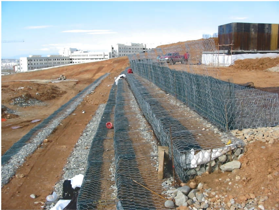
Φ24: Κατασκευή οπλισμένου επιχώματος περιοχής ελικοδρομίου στο νέο Στρατιωτικό Νοσοκομείο 424 Θεσ/νίκης. (Κ/Ξ 424 ΓΣΝΘ, 1910 – Δεκέμβριος 2002)
