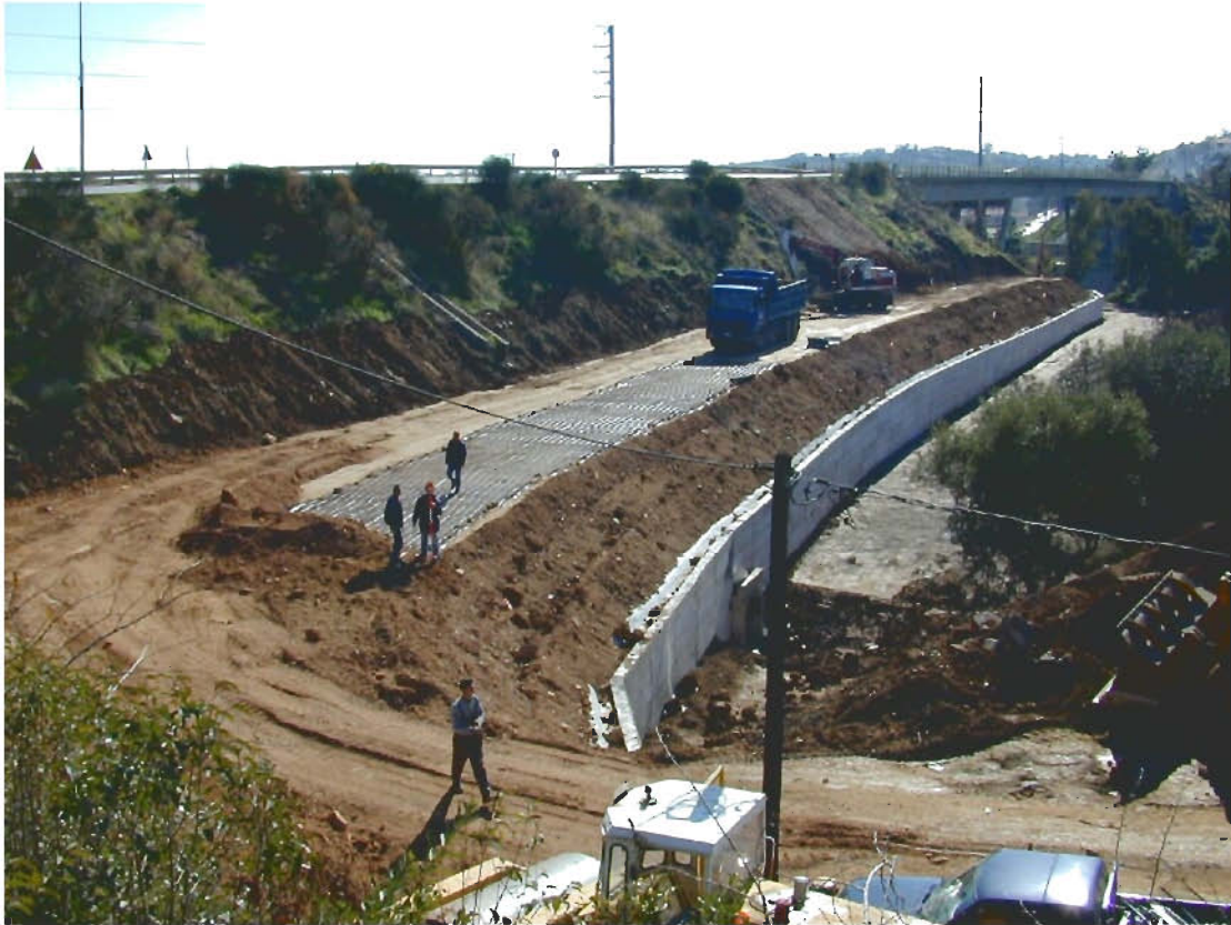
Φ8: Κατασκευή οπλισμένου επιχώματος Βορειοδυτικού ακρόβαθρου της γέφυρας της Ποτίδαιας (Ε.Ο.Α.Ε., 1513 - Νοέμβριος 2000)
