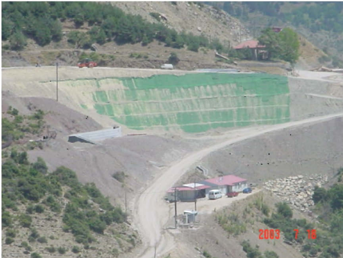
Φ22: Κατασκευή οπλισμένου επιχώματος 16 συνδετήριας οδού Α κόμβου Μετσόβου (Ε.Ο.Α.Ε., 1618 - Ιούλιος 2002)
