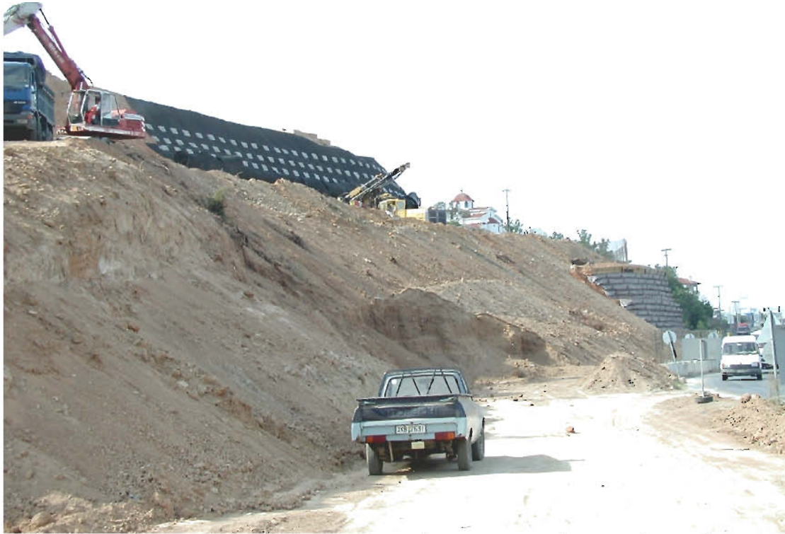
Φ17: Κατασκευή προσωρινού οπλισμένου επιχώματος για την μόνιμη σταθεροποίηση του ορύγματος με εδαφοηλώσεις στην περιοχή του αρχαιολογικού χώρου, Ποτίδαιας. (Ε.Ο.Α.Ε., 1513 – Ιούνιος 2001)
