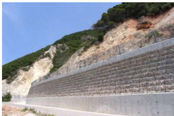
Λευκάδα - Σεισμός 2003 - Αποκατάσταση ολισθημένων πρανών
