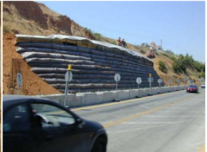
Ποτίδαia (οπλισμένα επιχώματα και εδαφοηλώσεις)
